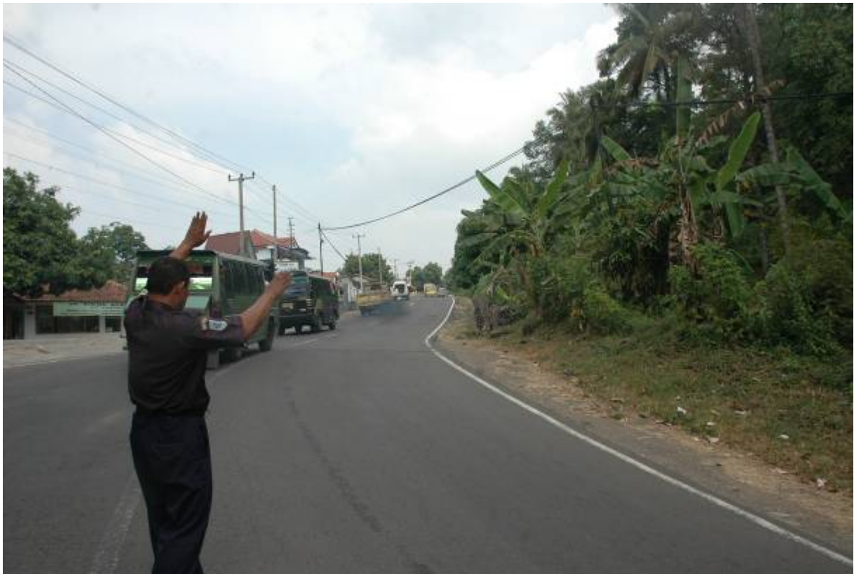
Gambar Prasarana 5 : Tidak terdapat tanda – tanda rambu lalu lintas dari arah Ciater pada belokan pertama ke tempat kejadian
