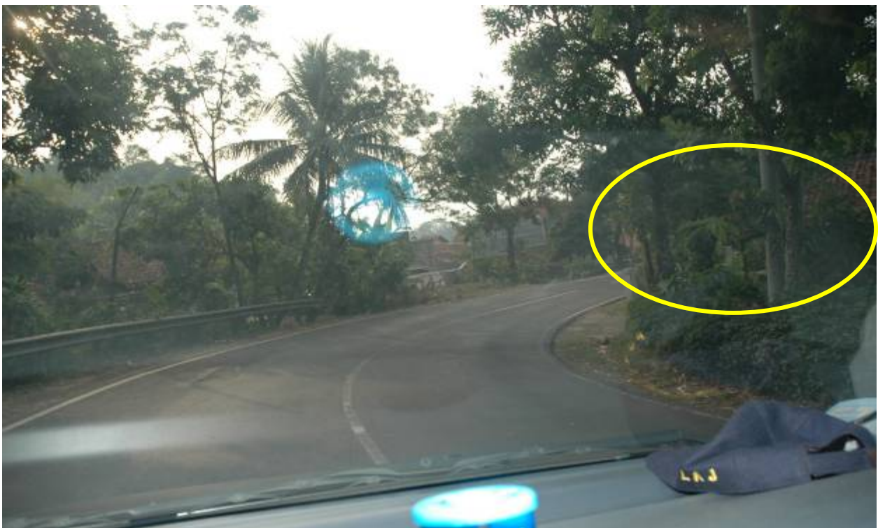
Gambar Prasarana 2 : Jarak pandang untuk melihat kendaraan yang datang dari arah berlawanan terhalang oleh pohon yang ada di sebelah kanan
