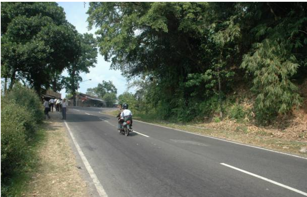
Gambar Prasarana 4 : Terdapat marka garis putus – putus sepanjang lokasi kejadian pertama sampai dengan lokasi kecelakaan kedua bus dengan mobil Feroza
